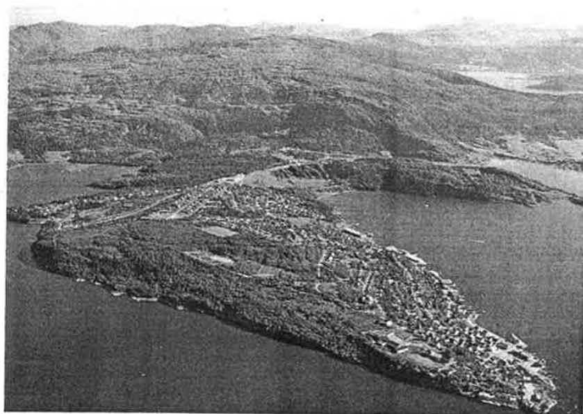
Flyfoto (Fjellanger Widerøe A/S, Oslo)
