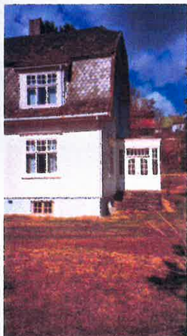
Lappheller av skifer på taket, glassveranda med typiske vinduer fra perioden.
