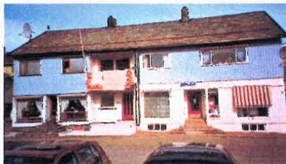
Torggata 4. Gjenreisningshus som har beholdt sin opprinnelige fasade
