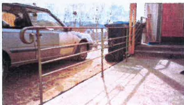
Detalje fra Sørlandsveien 23.
