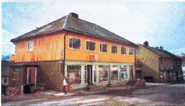
Sørlandsveien 19, bokhandel. Gjenreisningshus, jern-banepanel rundt butikkvinduene er erstattet med platekledning, ellers holdt i opprinnelig stil.
