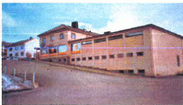
Samvirkebyggets fasade mot vest. Store vinduer er byttet ut med høysittende vinduer. Bildet er tatt fra Sjøgata, torget ligger oppå bakken til venstre for bildet.
