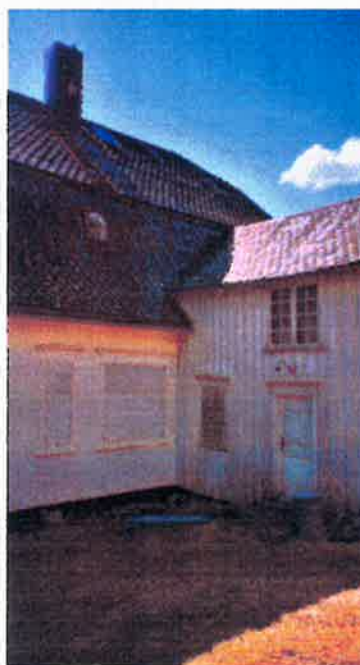
Baksiden med tilbygd uthus.
