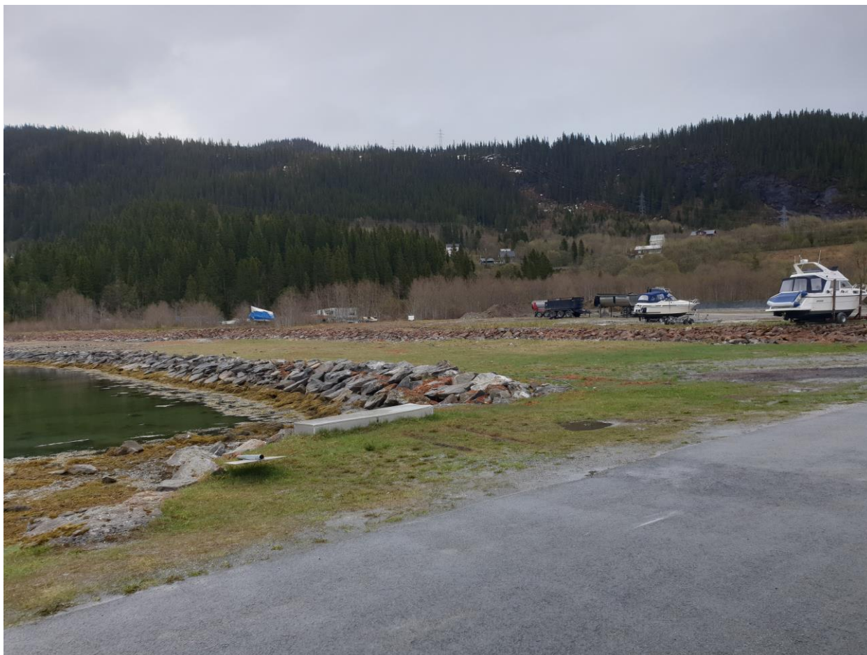
Figur 3: Bilde tatt på befaring 28.05.20. Viser fyllingen med to platå/høyder.
