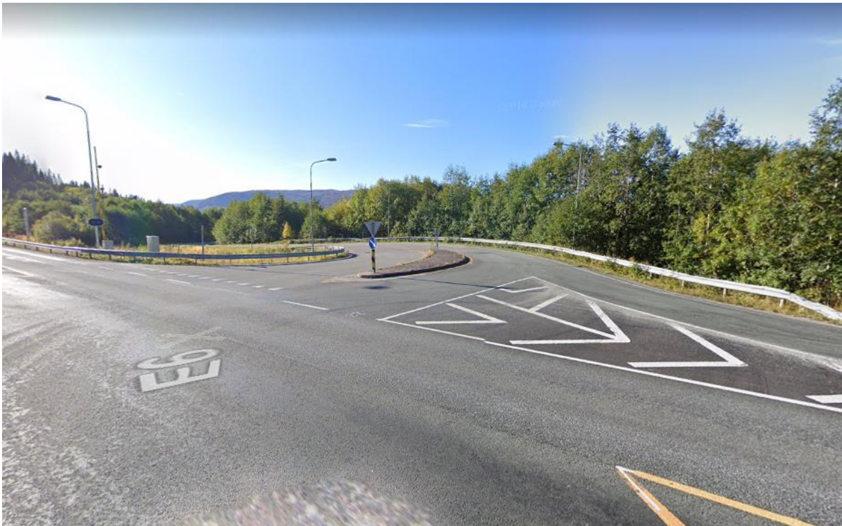
Bildet viser nordlig avkjøring Finneidfjord fra E6 – Google Street View
