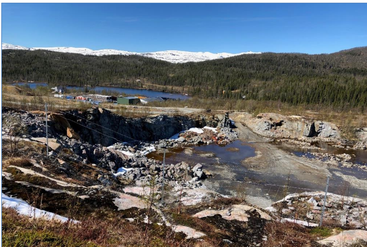
Figur 3-3: Dagbruddet med bygg i bakgrunnen tilhørende A/S Bleikvassli Gruber. Foto: R. Sundvor.
