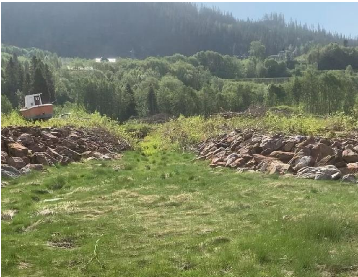
Grøfta sett fra motfyllingen og øst-sørøstover
